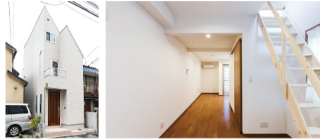
N邸新築工事
