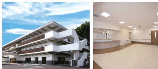
特別養護老人ホーム第二S移転改築工事
