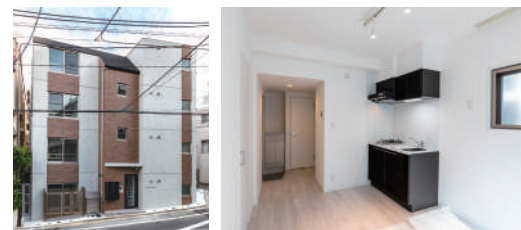
(仮称)南大塚3丁目計画新築工事
